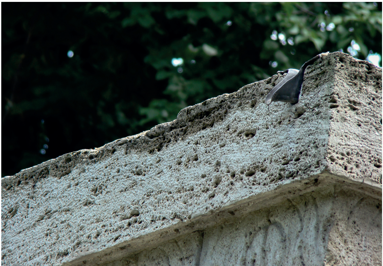
4.7. Linteau, côté Nord - attaque intégrée.
