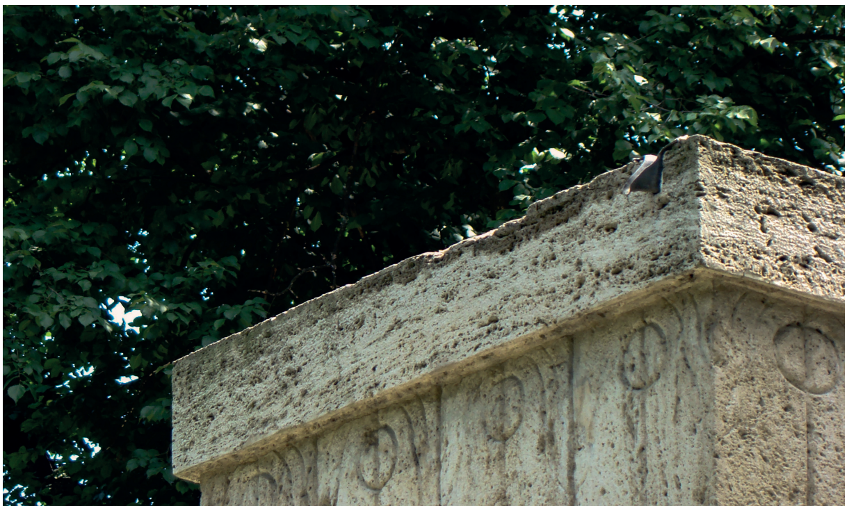
4.6. La Porte du Baiser, côté Nord - bio-attaque et dégradation physico-chimique
