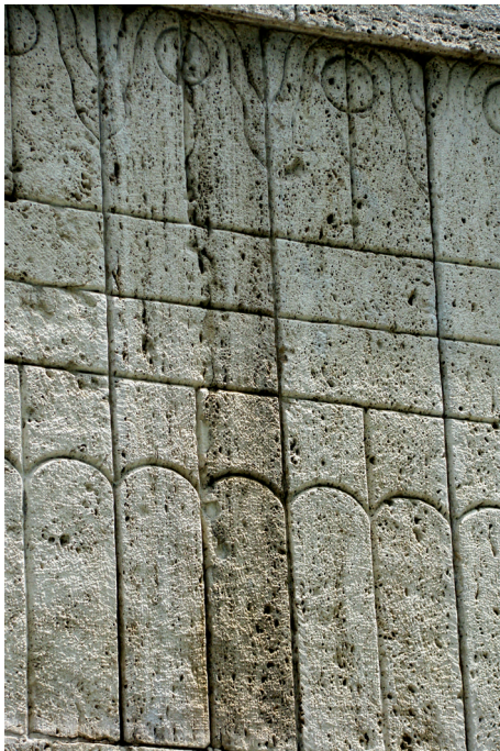
4.8. La Porte du Baiser, côté Nord exsudation des sels
