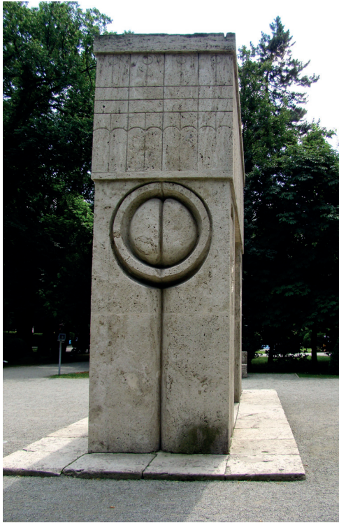
4.10. La Porte du Baiser, côté Nord attaque biologique
