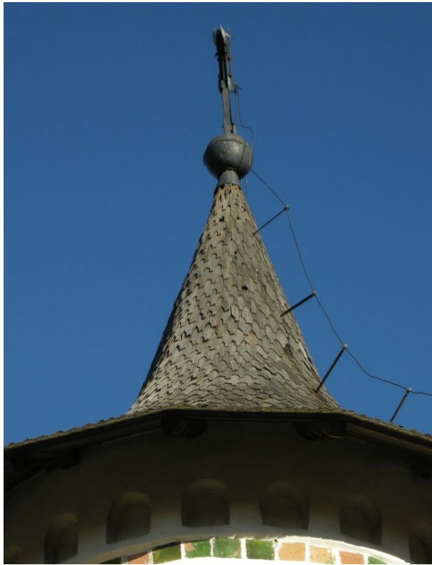
Degradări ale acoperișului din șită al Bisericii „Înălțarea Sfintei Cruci” din Pătrăuți
